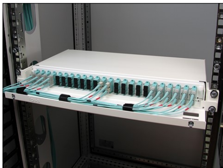
1U panel med integrert 0.5U kabelrenne. Totalt 1U
